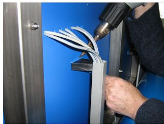
(c) Anschweißen eines Kabelkanal-Sattels
